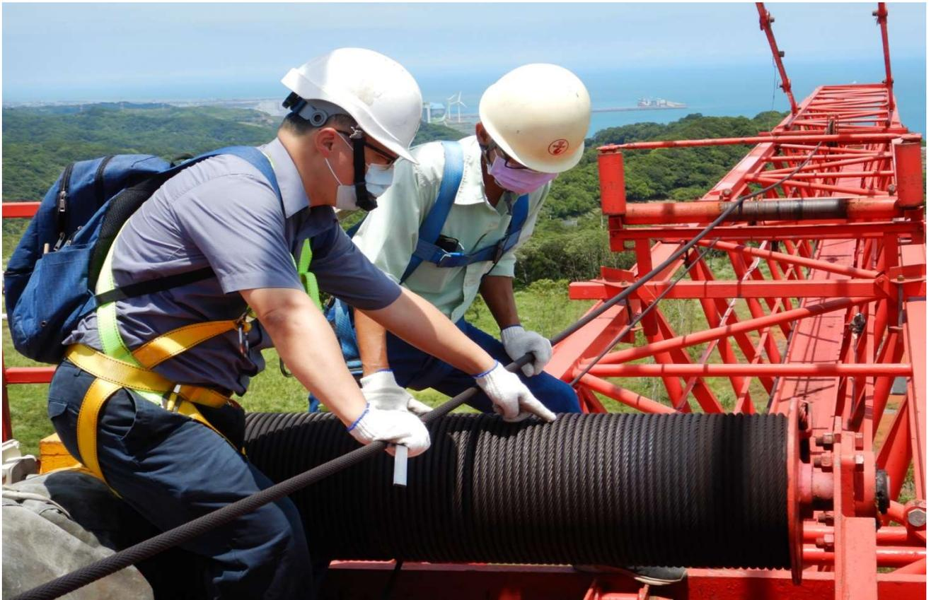
代行檢查機構檢查員至塔吊伸臂處檢查確認鋼索狀況
